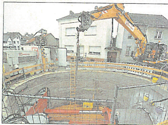
Die Grube an der Ecke Villiper Hauptstraße/Gimmersdorfer Straße in Villip ist 4,35 Meter tief. Unten rechts sieht man ein Rohrstück. FOTO: VOGEL
