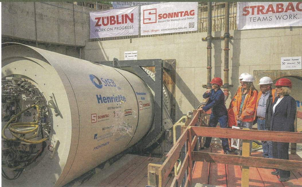
Start des Tunnelbaus unter dem Rhein: Oberbürgermeisterin Henriette Reker tauft die Vortriebsmaschine. | Foto: StEB Köln/Peter Jost
