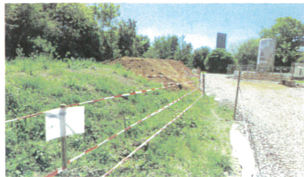
Baustraße, differenzierte Lagerung von Unter- und Oberboden
