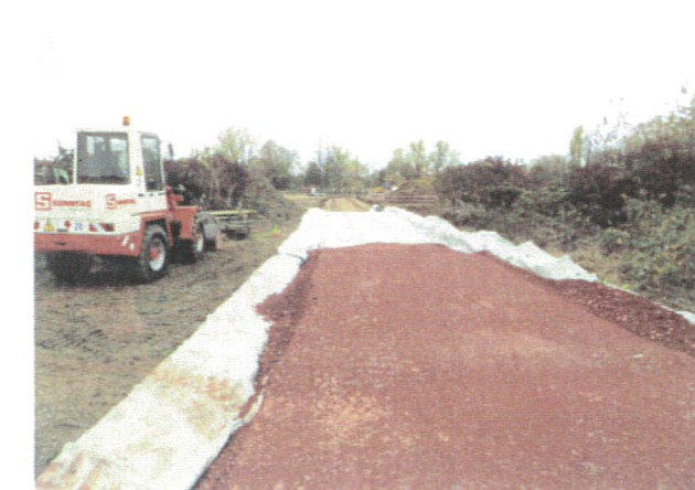
Anlegen der Baustraße auf Geotextil
