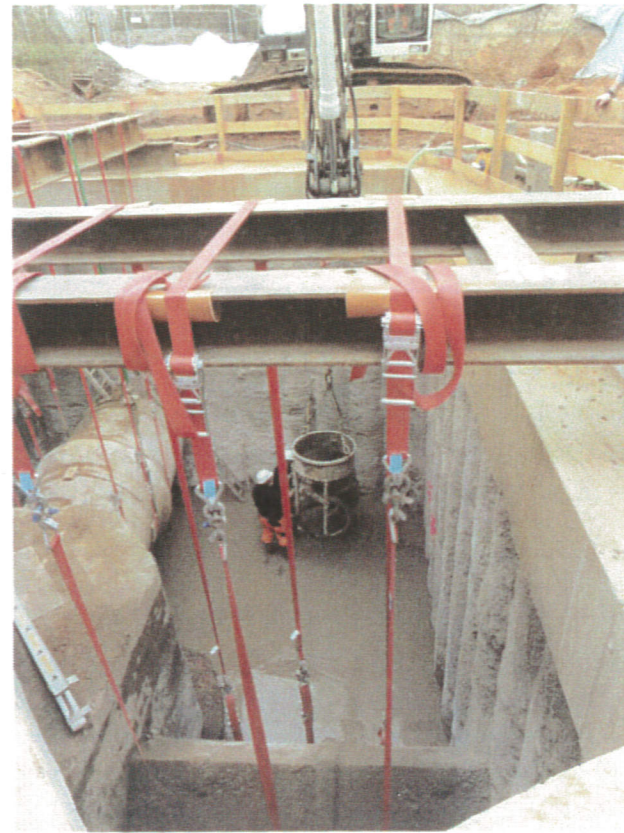
Zielgrube 4.0-1 mit Aufhängung der bestehenden Hauptsammler 3.0 „Wallerfanger Straße“ und 4.0 „West“
