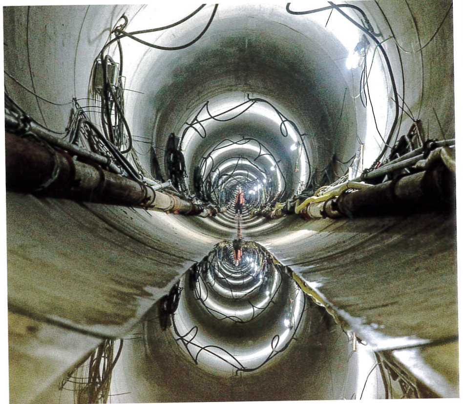
Eine interessante Perspektive mit Spiegelbild. Deutlich zu erkennen das Gefälle bis zu dem Düker-Tiefpunkt von 12 m unter der Gewässersohle des Rheins
