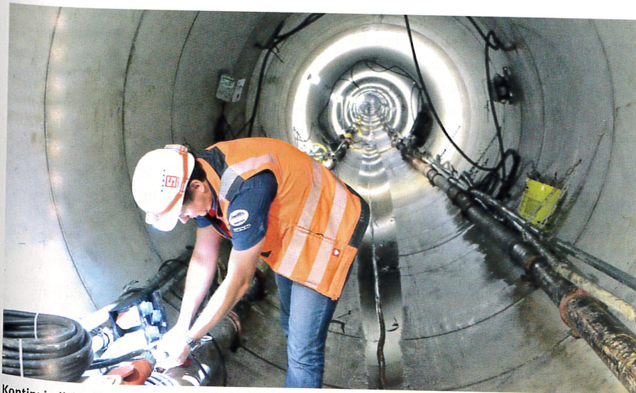
Kontinuierlicher Tunnelvortrieb durch begleitende Wartungsarbeiten
