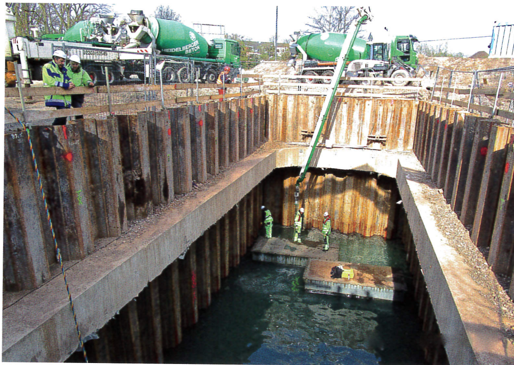
Einbau des Unterwasserbetons in die bis zu 13 m tiefe Startbaugrube durch Spezialtaucher
