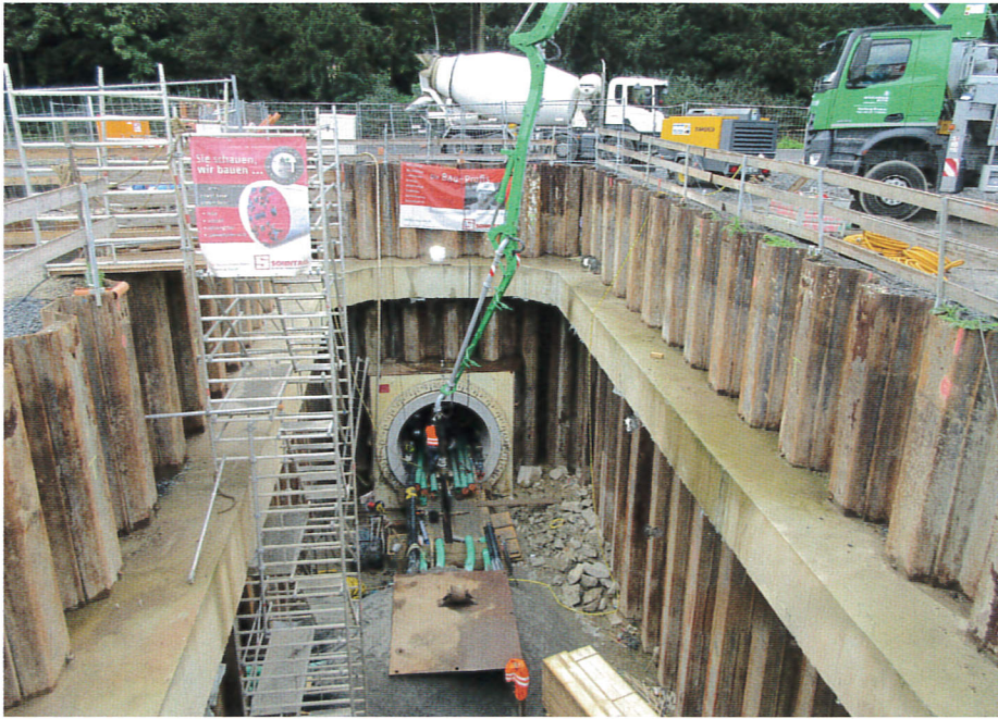
Einbringen des Sohlbetons im Düker über die Zielgrube mit 36 m Betonpumpe sowie über die Startbaugrube mit Pumplängen von bis zu 350 m
