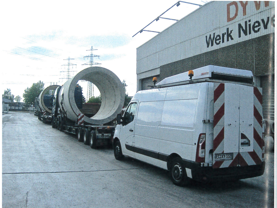
Eine logistische Herausforderung: Die rund 158 und 33 t schweren Vortriebsrohre DA 3400 sowie fünf Zwischenpress-Stationen wurden genau auf den Einbautakt abgestimmten Zeiten vom Werk auf begleiteten Schwerlastfahrzeugen zur Baustelle transportiert
