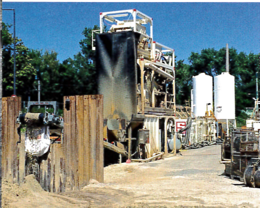
Baustelleneinrichtung mit groß dimensionierter Separieranlage für den Rohrvortrieb
