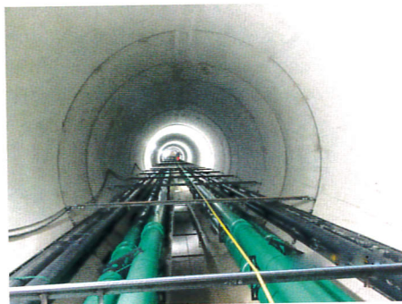
Nach dem erfolgreichen Einbau der Kanalrohre erfolgte zunächst die Montage der Leerrohre für die 210kV-Systeme sowie die Kommunikation
