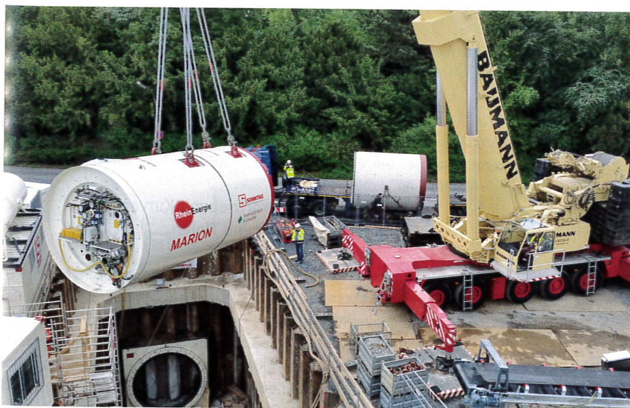
Kein Leichtgewicht selbst für einen 500-t-Kran: die rund 100 t schwere Microtunneling-Vortriebsmaschine beim Einheben in die Startbaugrube
