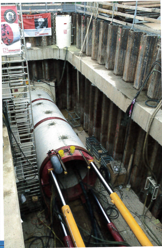
Startbaugrube mit Presseinrichtungen während des Vortriebs
