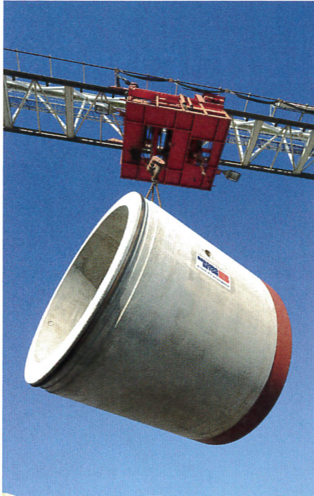
Eine logistische Herausforderung: Die rund 158 und 33 t schweren Vortriebsrohre DA 3400 sowie fünf Zwischenpress-Stationen wurden genau auf den Einbautakt abgestimmten Zeiten vom Werk auf begleiteten Schwerlastfahrzeugen zur Baustelle transportiert
