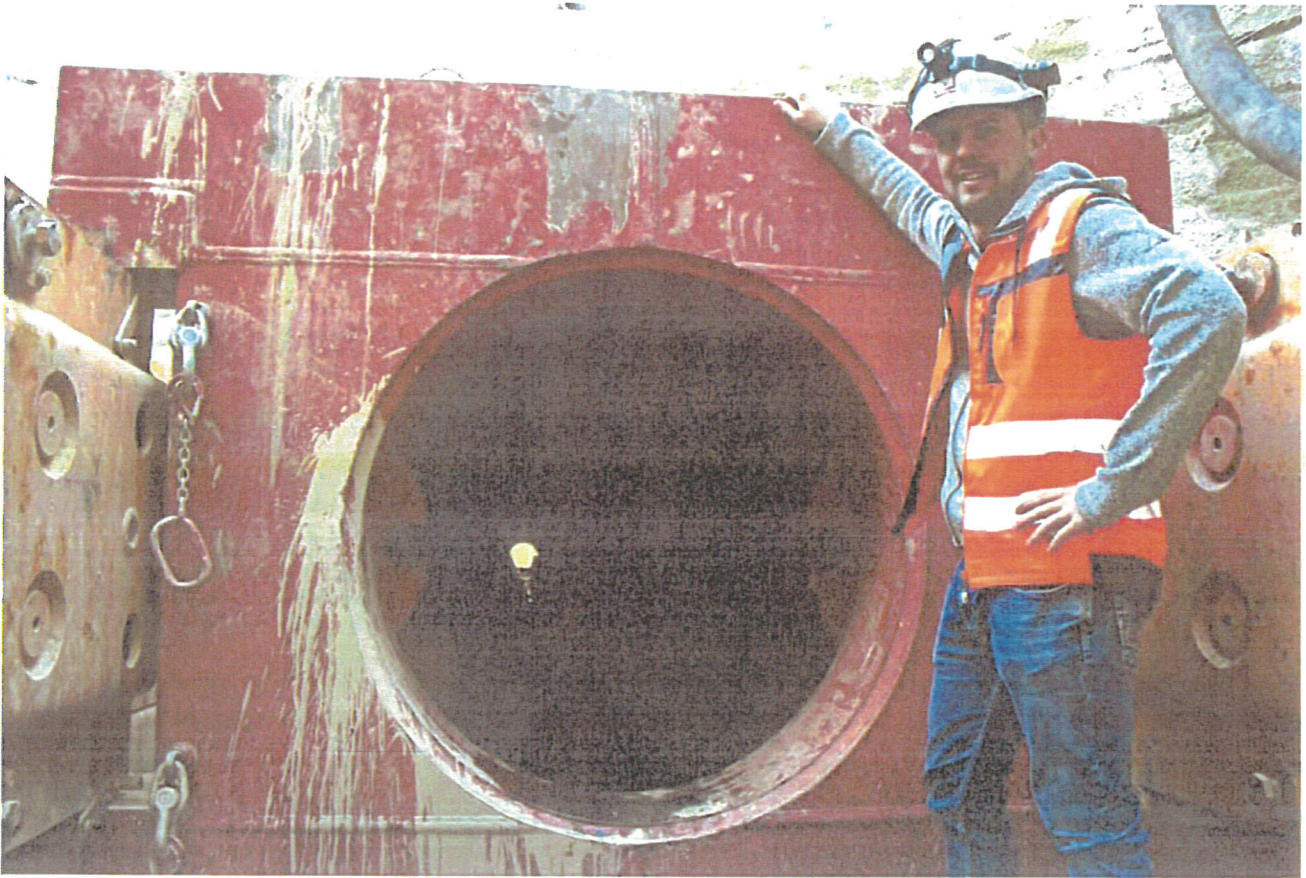
Licht am Ende des Tunnels kann Bauleiter Maximilian Vogt in der Bogenstraße sehen., Anne Rheingans
