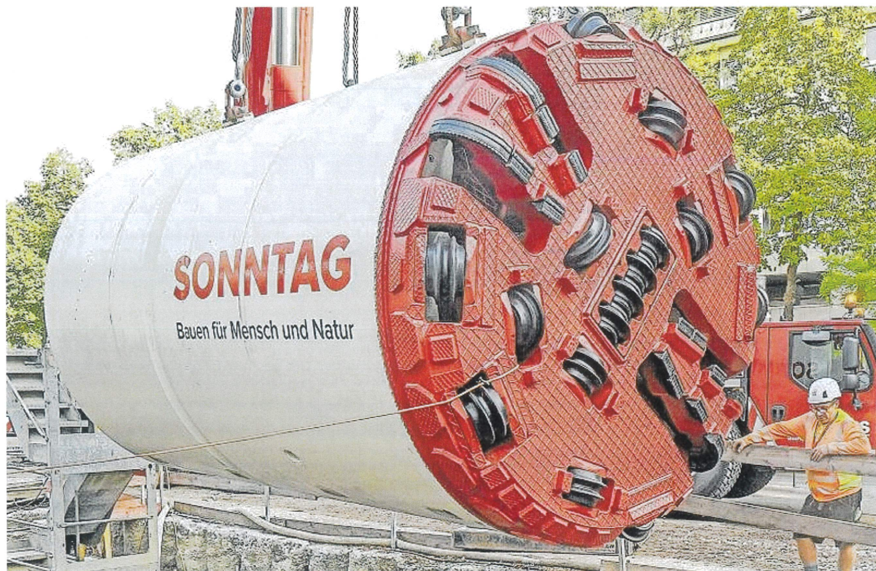
Am frühen Morgen wurde der 60 Tonnen schwerer Bohrkopf per Schwertransport angeliefert und dann in die 12 Meter tiefe Baugrube befördert. Foto: Fischer
