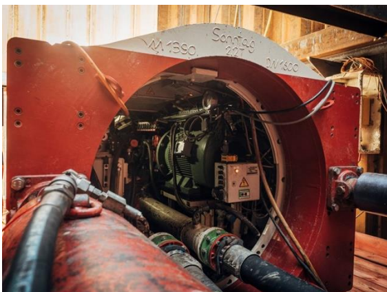
Startklar - Blick ins Innere der Tunnelbohrmaschine (Foto: Daniel Seiffert)
