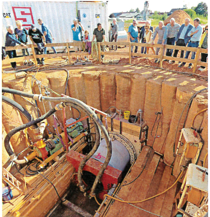
Gewaltige Rohre mit einem Innendurchmesser von 1,4 Meter werden in Saarlouis in rund sechs Metern Tiefe durch den Boden gepresst.
