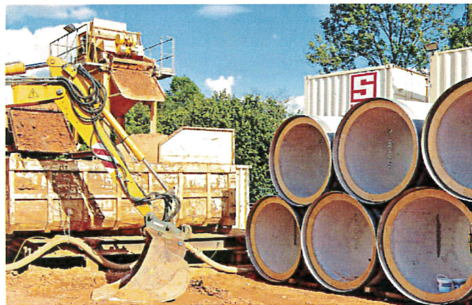
Dicke Rohre liegen bereit für den Abwassersammler West in Saarlouis; im Hintergrund rieselt der aus dem Untergrund herausgebohrte Buntsandstein in einen Kipper und wird gewogen.
