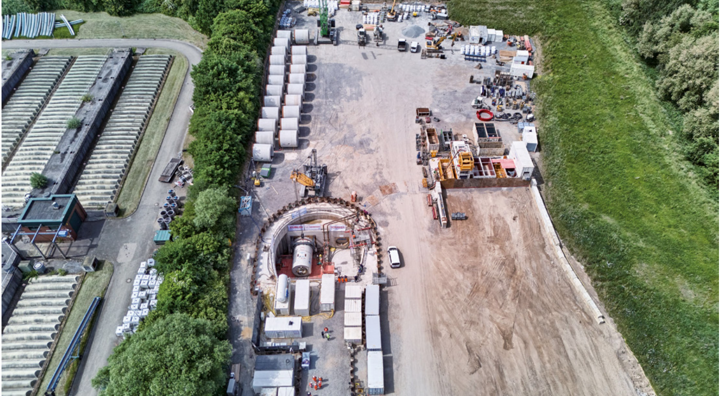
Baustelleneinrichtungsfläche bei der Startbaugrube | Foto: Sonntag Baugesellschaft
