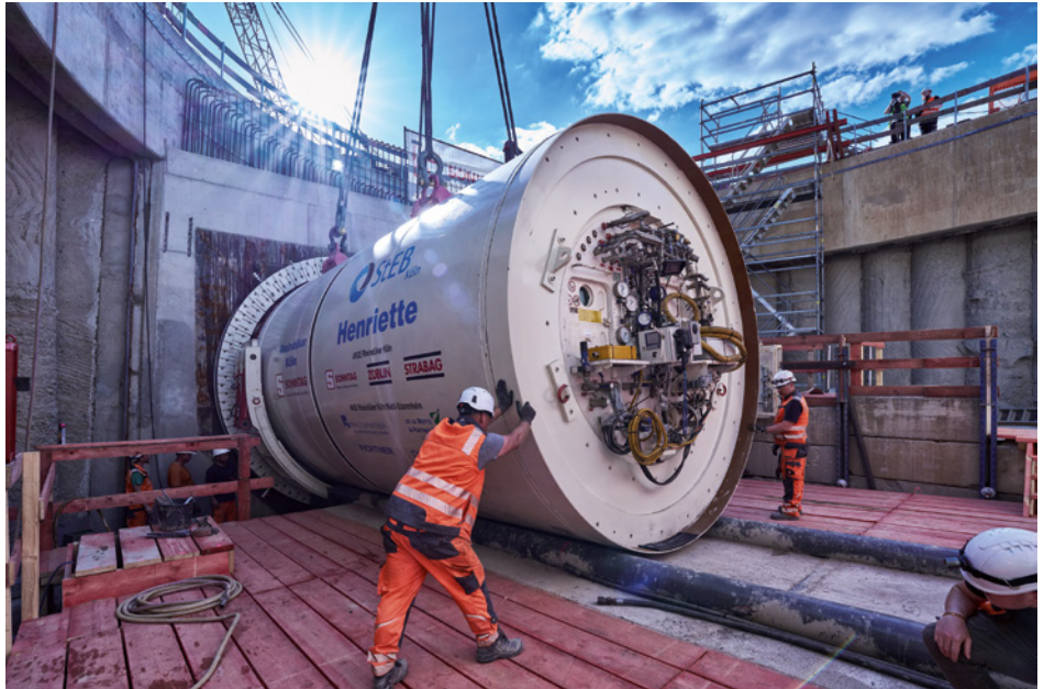
Positionierung der Vortriebsmaschine auf der Schildwiege | Foto: Sonntag Baugesellschaft
