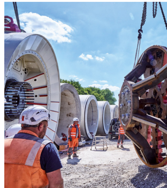
Montage Schneidrad der TBM auf Baustelle | Foto: Sonntag Baugesellschaft
