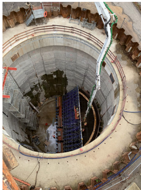
Betonage Einfahrblock Zielschacht | Foto: Sonntag Baugesellschaft
