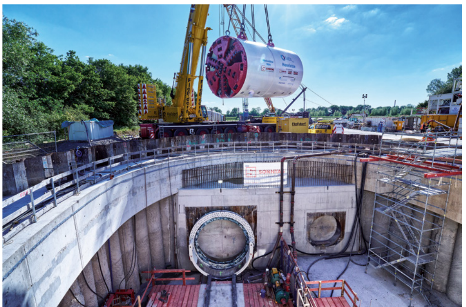
Die 131 Tonnen schwere Tunnelbohrmaschine „Henriette“ wird mit Hilfe eines 750-Tonnen-Mobilkrans in den Startschacht eingehoben. | Foto: Sonntag Baugesellschaft
