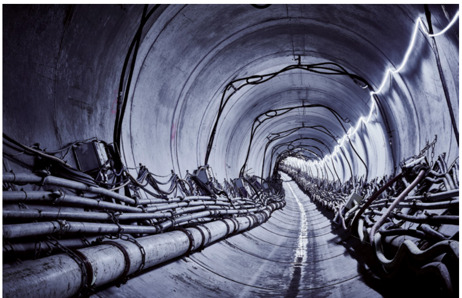
Vortrieb in Raumkurve – Tunnelröhre DN 3200 | Foto: Sonntag Baugesellschaft
