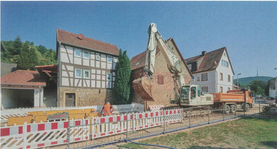
Anspruchsvolle Kanalerneuerung in Sulzbach am Main. In wechselnder Geologie musste der Kanal vergrößert und ein Regenüberlaufsystem gebaut werden.
