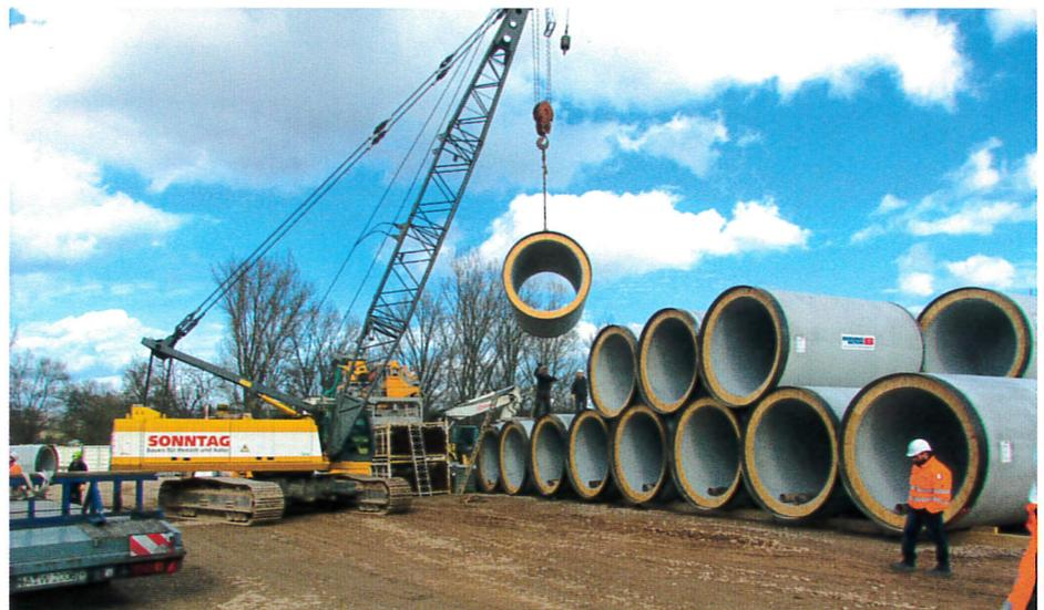
Insgesamt waren 314 Stahlbeton-Vortriebsrohre (DN 2000) für die erfolgreiche Umsetzung des Projektes erforderlich. | Fotos: Berding Beton GmbH
