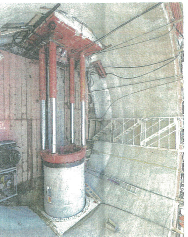
Von einem Grundstück an der Speyerer Straße aus wird derzeit ein Abwasserkanal mit zwei Metern Durchmesser in Richtung Bahnstadt gebaut.
