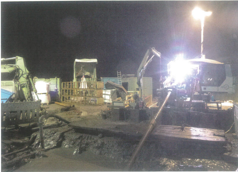
Pilotbohrung mit dem Sendergehäuse des Gyro | Foto: De la Motte & Partner GmbH
