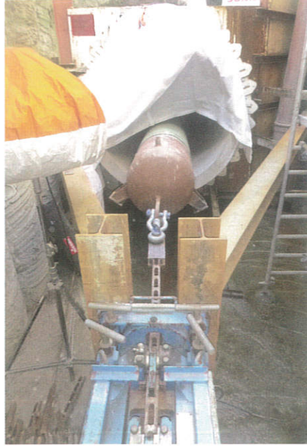
Abschluss des Einzugs der Produktleitung in die Zielbaugrube mit Widerlager für die Zugeinrichtung | Foto: De la Motte & Partner GmbH
