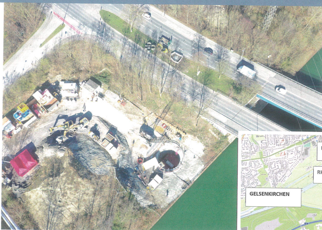
Baustelleneinrichtung von oben | Foto: Open Grid Europe
