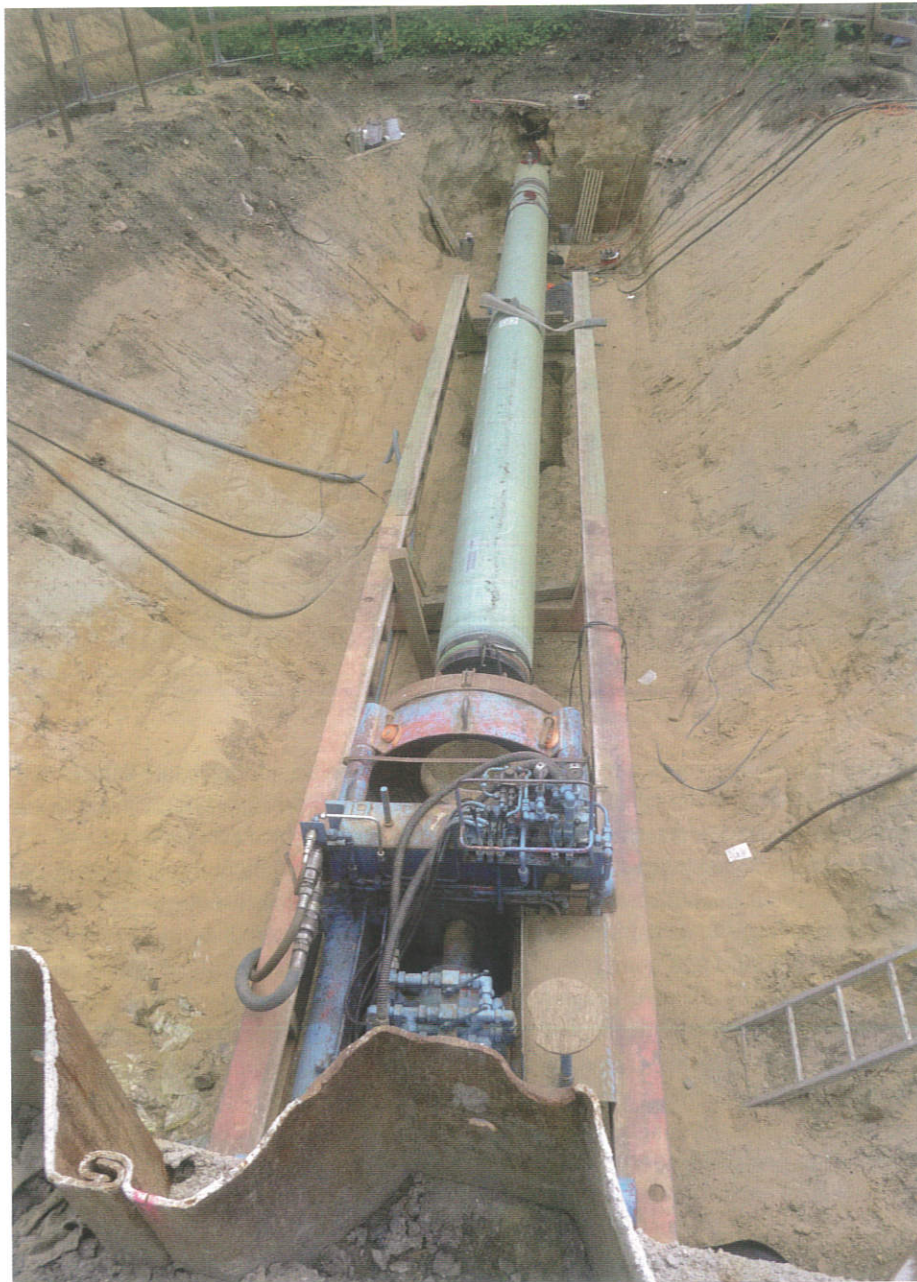
Horizontalbohrpressanlage; Vortrieb des Produktrohrs von der Startbaugrube aus | Foto: De la Motte & Partner GmbH
