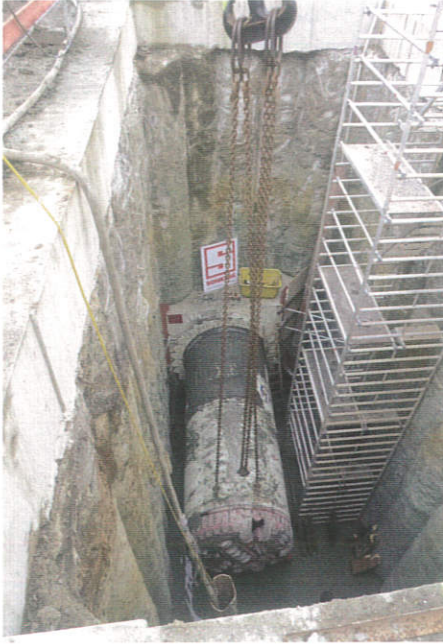
Bergung der Tunnelbohrmaschine AVND1600AB aus der Zielbaugrube | Foto: De la Motte & Partner GmbH
