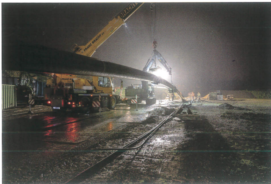
Einzug Produktrohrstrang nebst Kabelschutzrohren | Foto: De la Motte & Partner GmbH
