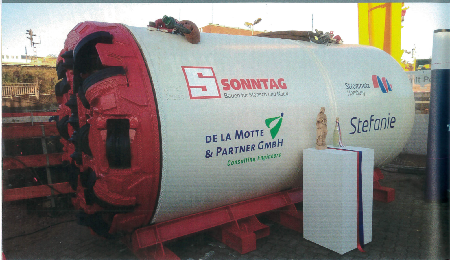
Abb. 1: Tunnelbohrmaschine „Stefanie“ vor Beginn der Arbeiten
