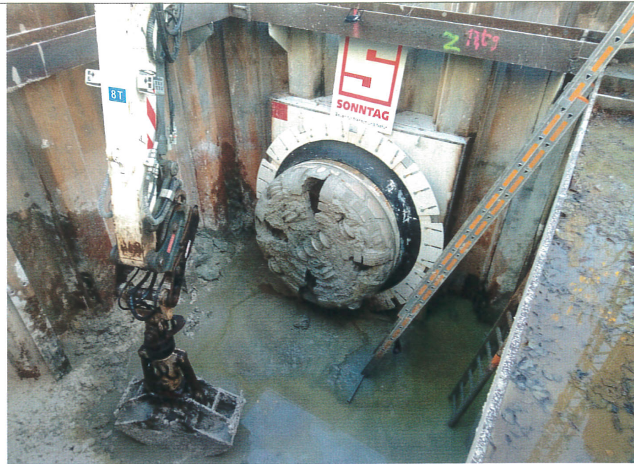
Abb. 5: Schneidrad der Tunnelbohrmaschine nach dem Einfahren in die Zielbaugrube
