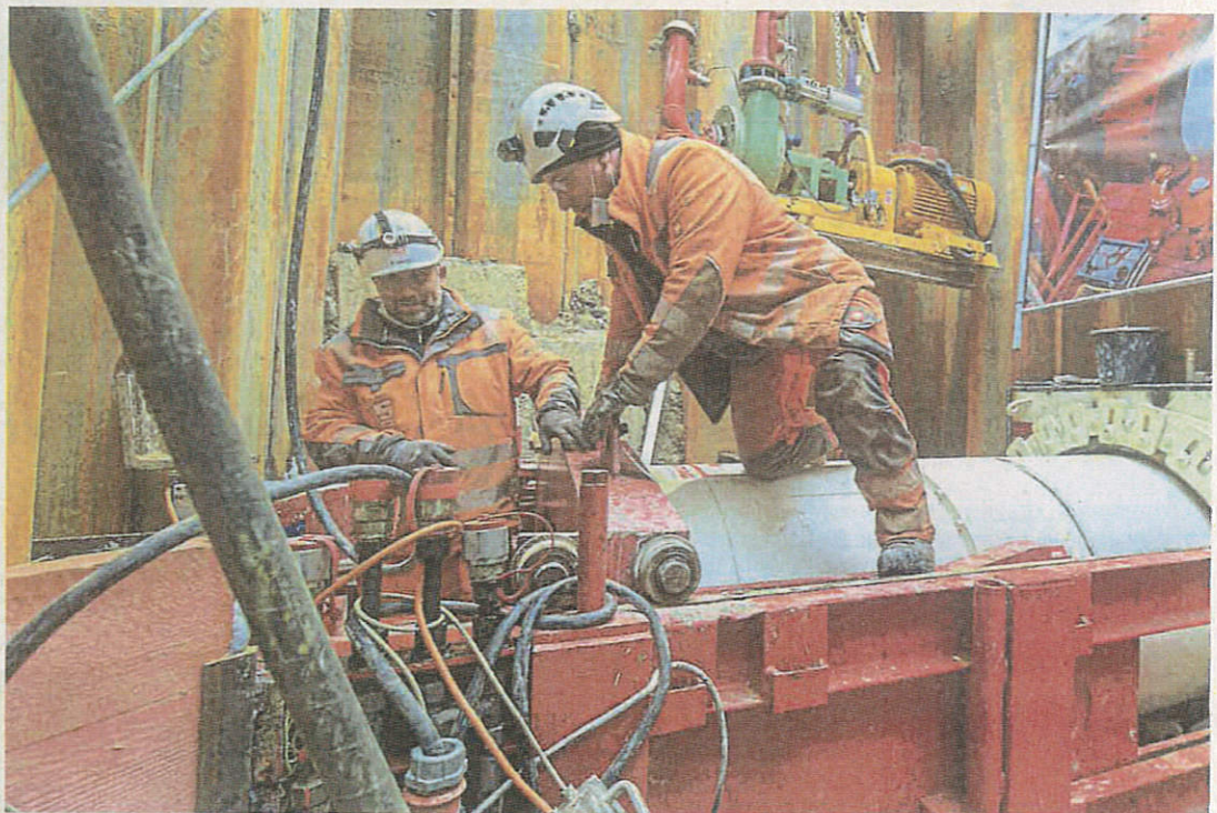
Bohrmeister Ronny Dorow und Vortriebsmitarbeiter Dominic Hanninger (von links) arbeiten derzeit daran, dass der neue Kanal auf dem Gelände der Kläranlage verlegt werden kann. Foto: Robert Heiler
