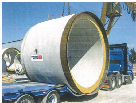
Der liegende Transport der 135 Stahlbeton-Vortriebsrohre von Berding Beton brachte gleich mehrere Vorteile mit sich.
