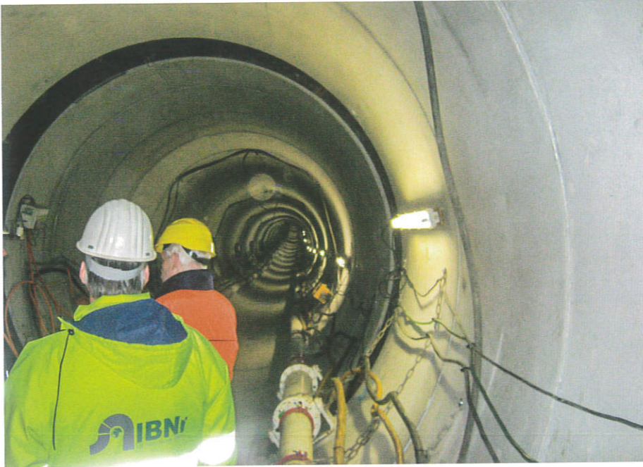
Fertig gestellter Medienkanal | Fotos: Berding Beton
