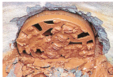
Mit 50 Millimetern pro Minute frisst sich der rund 1,5 Meter hohe Bohrkopf in einer Tiefe von fünf Metern durch die Betonhülle. FOTO: JOHANNES A. BODWING
