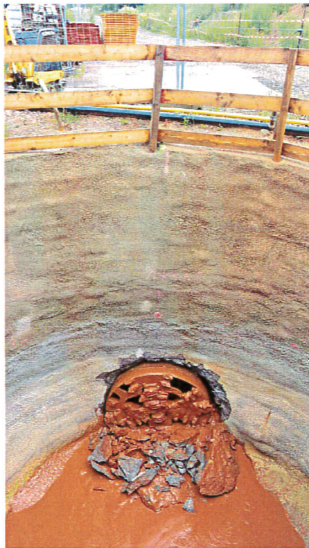
Der mächtige Bohrkopf durchbricht im Untergrund eine mehrere Zentimeter dicke Betonhülle. FOTO: JOHANNES A. BODWING
