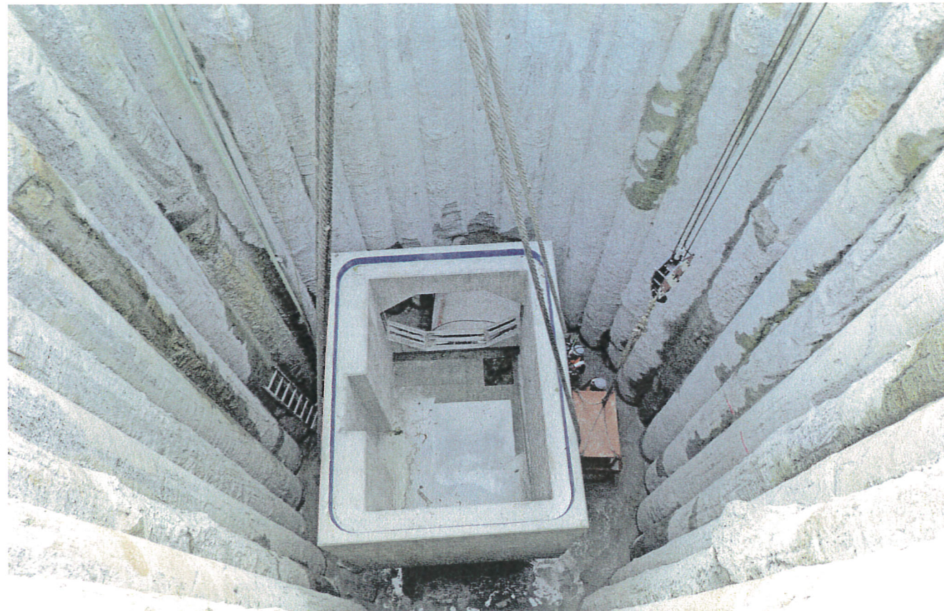
Einsetzen des ersten Stahlbetonfertigteils in den etwa 11 m tiefen Schacht.
