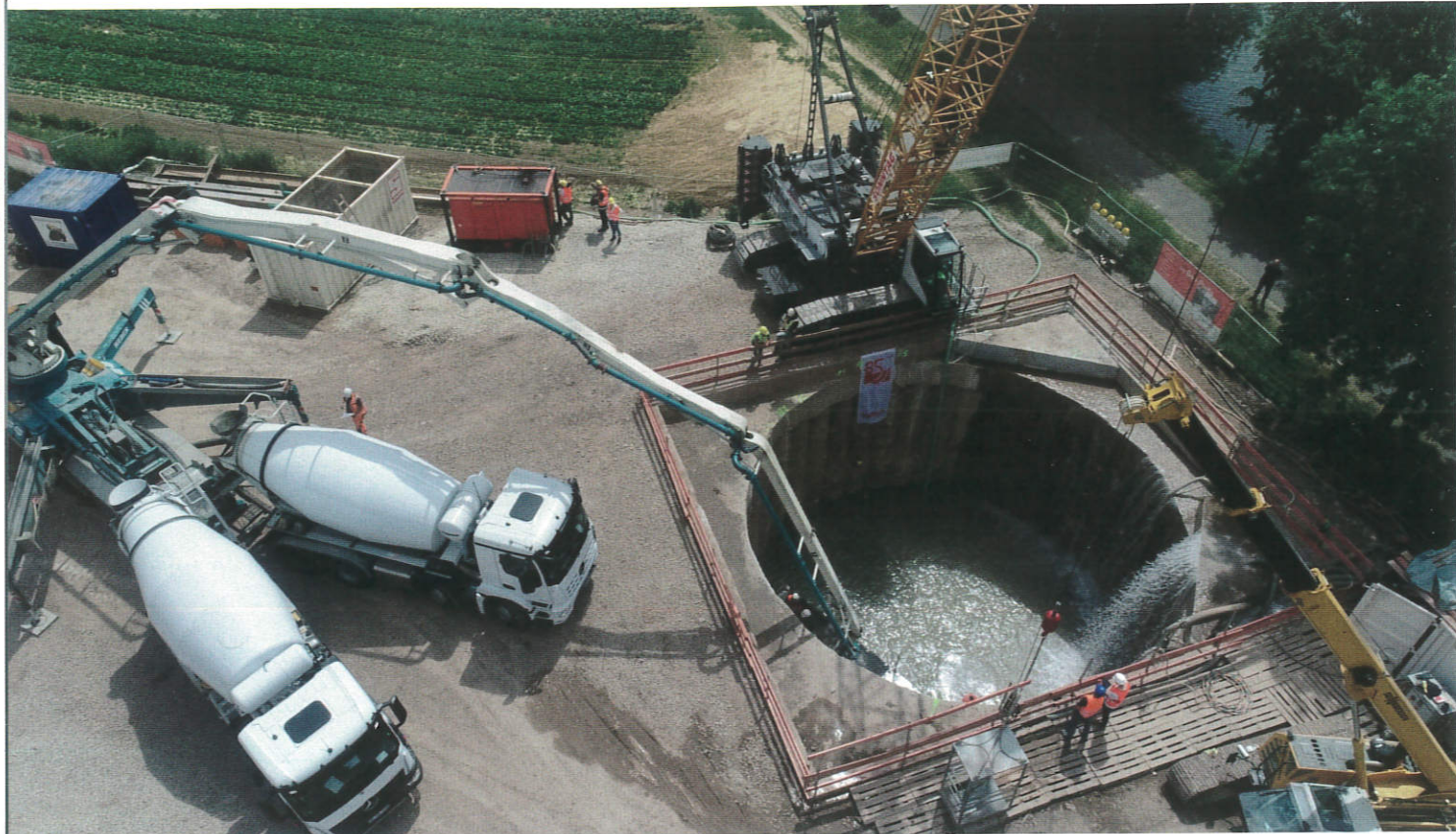
Unterwasserbetonage der Startgrube. 283 cbm Beton wurden in 8 Stunden eingebaut.
