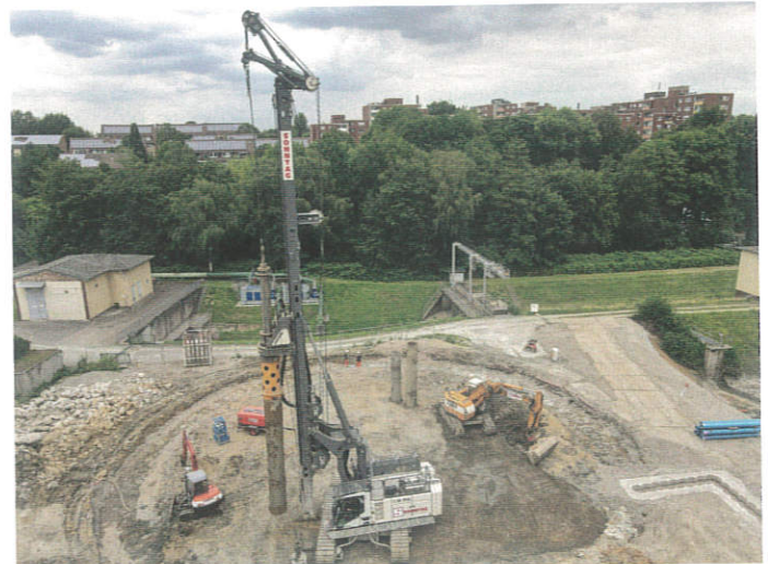
Baugrubenherstellung mit dem Großdrehbohrgerät
