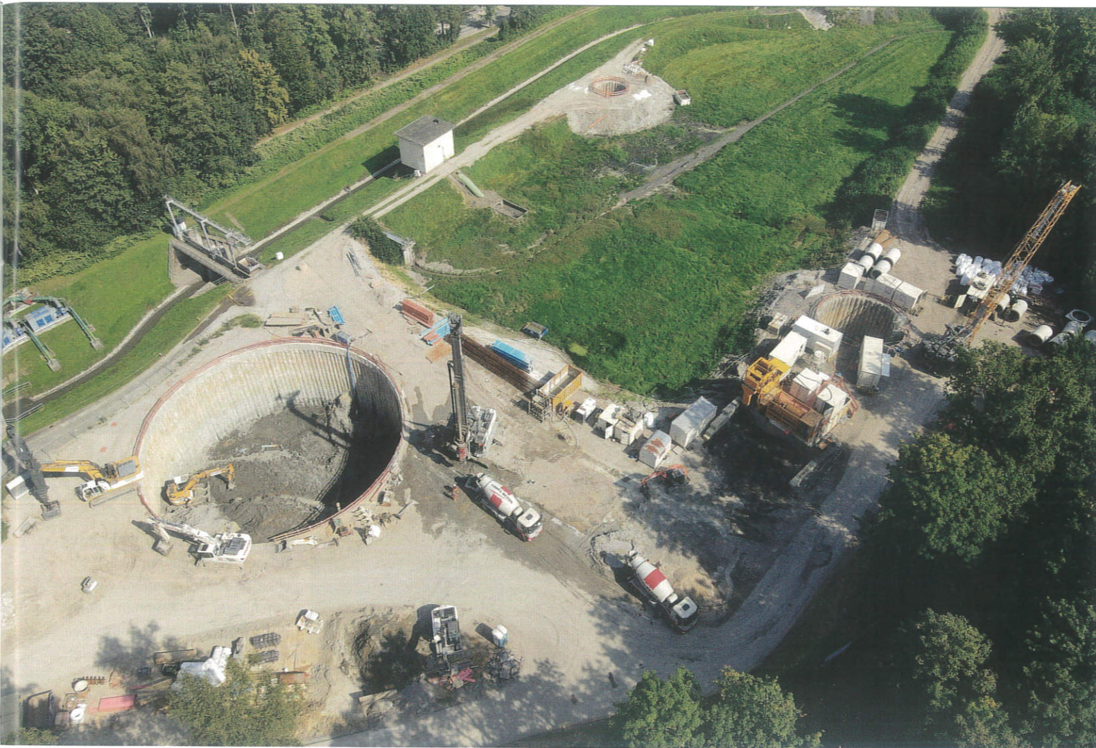
Baustelle mit den verschiedenen Baugruben
