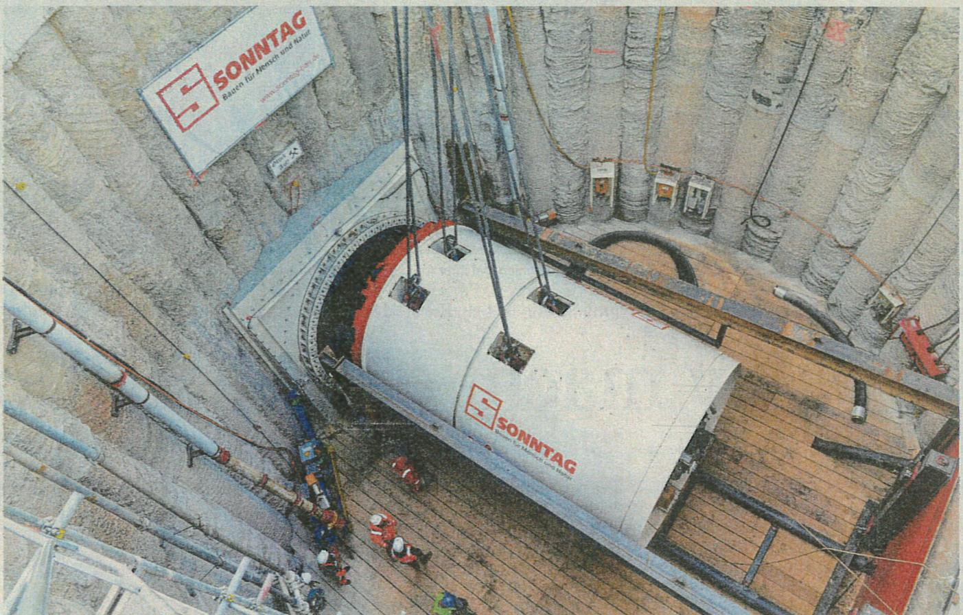
**MANNHEIM.** Die Anbindung der Friesenheimer Insel an das Mannheimer Fernwärmenetz geht in die nächste Phase: Gestern ist die 120 000 Kilogramm schwere Bohrmaschine „Stefanie“ von einem Kran in die Grube hinabgelassen worden. Ab Montag
