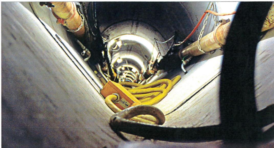
Über 1000-Volt-Kabel klettern heißt es beim Gang durch die Wasserleitung, die nur 1,60 Meter hoch ist.
