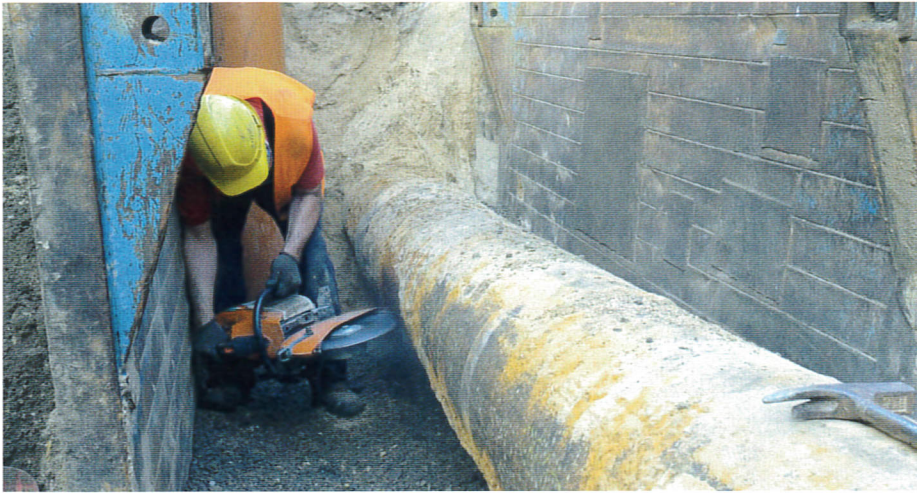
Trennen der alten Wasserleitung DN 400. | Foto: SWO Netz GmbH
