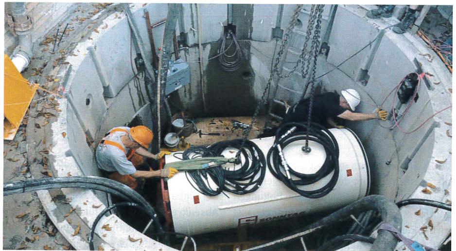
Präzisionseinbau der Vortriebsmaschine in den Startschacht. | Foto: SWO Netz GmbH
