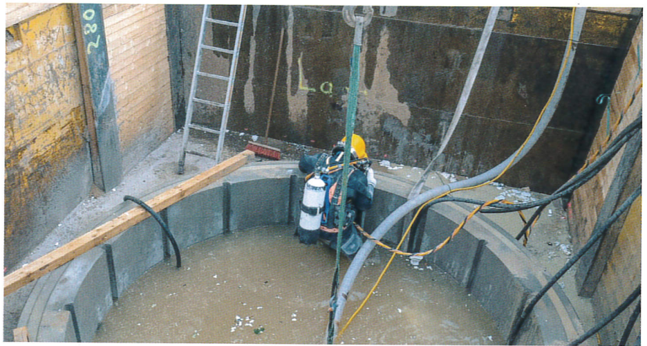
Absaugen des Bentonits und betonieren der Unterwasserbetonsohle. | Foto: SWO Netz GmbH
