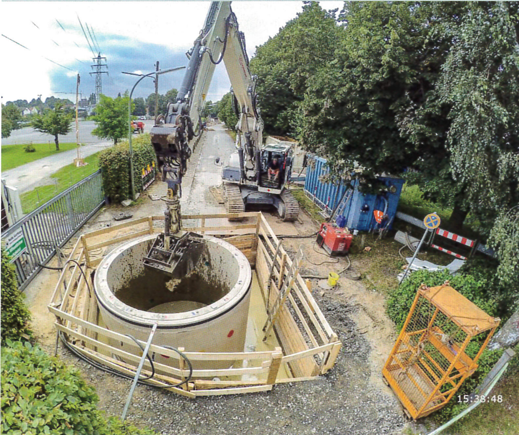
Absenkvorgang eines Startschachtes. | Foto: SWO Netz GmbH
