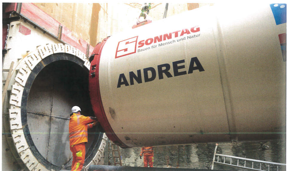
Der Bohrkopf wird in die Schildwiege eingehoben. | Foto: Sonntag Baugesellschaft mbH & Co. KG
