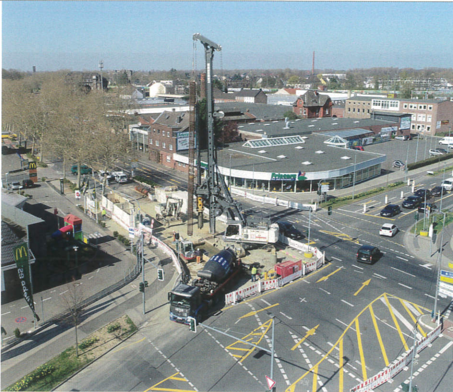
Mitten in Viersen wird ein 2,5 km langer unterirdischer Regenrückhaltekanal gebaut, in dem das Regenwasser wie in einer Tiefgarage zwischengeparkt wird. | Foto: NEW AG
