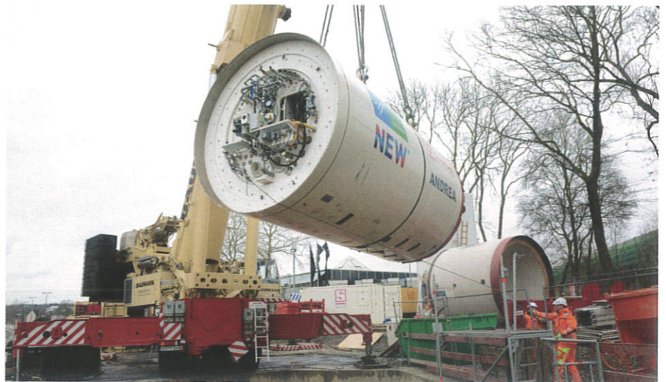
Einheben des 120 t schweren Bohrkopfes in die Baugrube | Foto: Sonntag Baugesellschaft mbH & Co. KG
