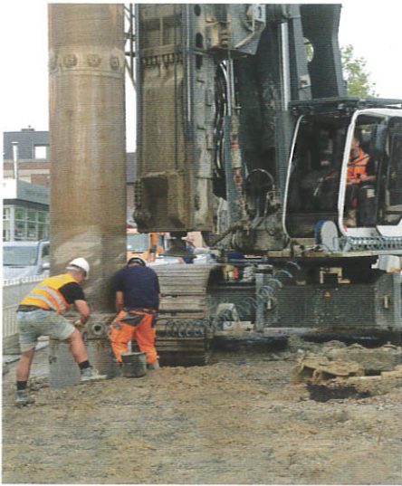
Über mehrere Monate waren Großdrehbohrgeräte parallel im Einsatz, um die bis zu 23,5 m langen Bohrpfähle herzustellen. | Foto: Sonntag Baugesellschaft mbH & Co. KG
