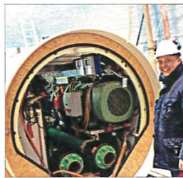
Christoph Herkommer in der Startgrube: Die Vortriebsmaschine, neben der er steht, wird durch den Boden geschoben.
