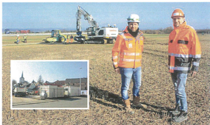
Baustart an der A4 bei Kraftsdorf: Ein großer Tag für Oberbauleiter Manuel Rautenberg (links) von der Firma Sonntag und Axel Happe von Auftraggeber 50 Hertz Transmission GmbH. In Thieschitz (kleines Foto) haben die Bauleute der Firma Sonntag ihr Lager aufgeschlagen.
