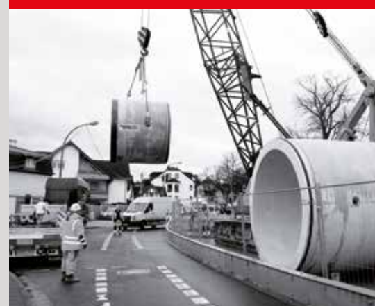
Startgrube des Teilschnittvortriebes DN 2600
