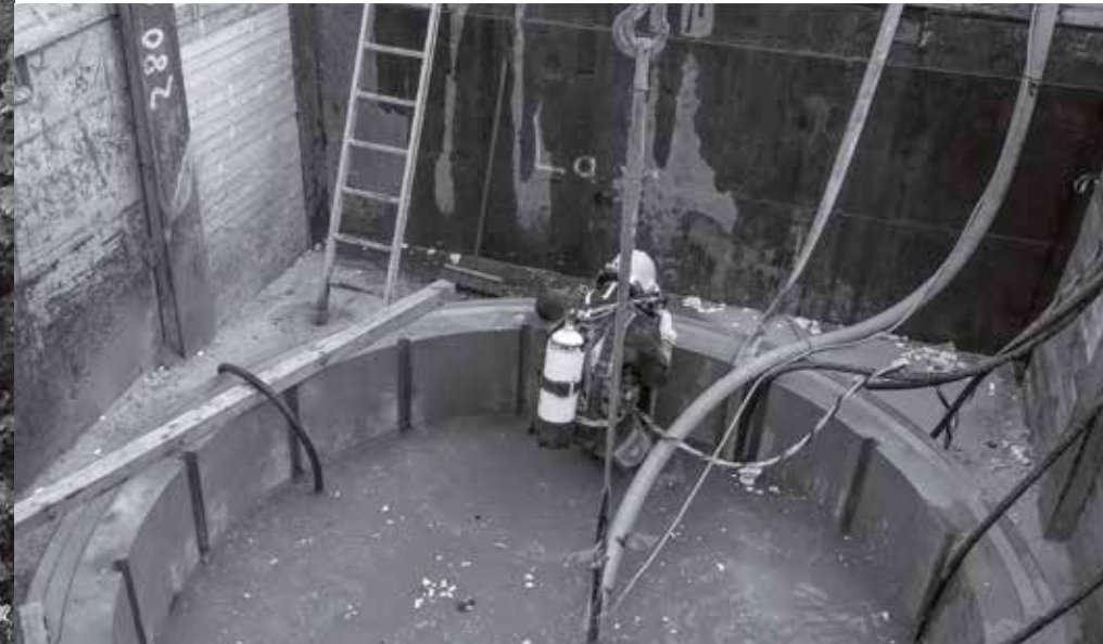
Tauchereinsatz zur Herstellung der Unterwasserbetonsohle.
