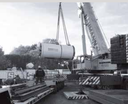
Vortriebsmaschine beim Anfahrvorgang
